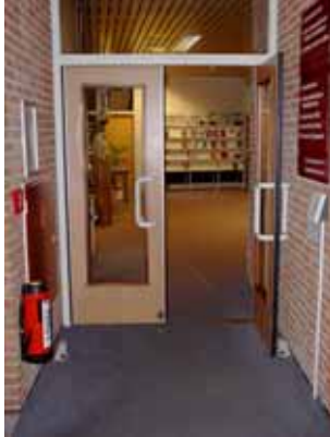
Van een dubbele deur moeten beide bladen minimaal 850 mm doorgang bieden.
