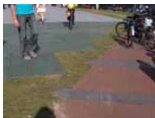
Rubberen matten moeten wel aansluiten op een verharde ondergrond.
